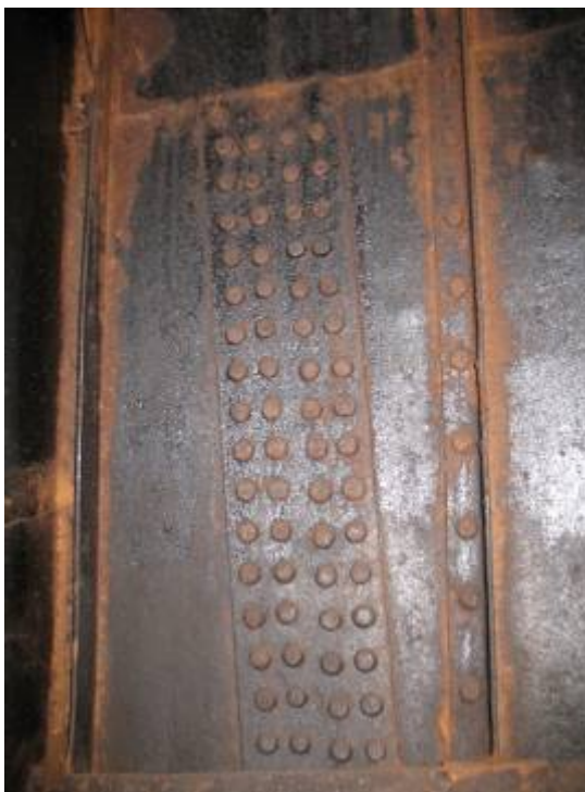
Billeder af lask, spant, nitter.
