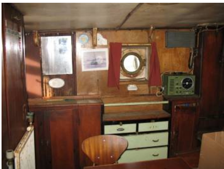
Agterapteringen som den fremstår i dag, svært fugtskadet
